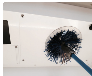
5. Dra loss kontrollventilen. Kanalen blir direkt åtkomlig för rensning
